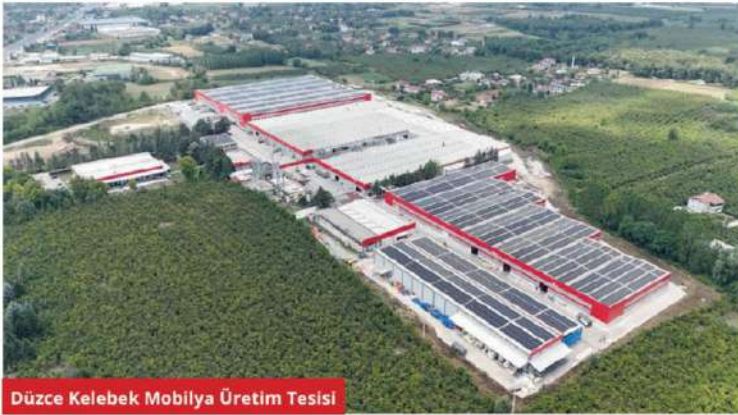
Düzce Kelebek Mobilya Üretim Tesisi
