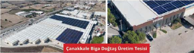
Çanakkale Biga Doğtaş Üretim Tesisi
